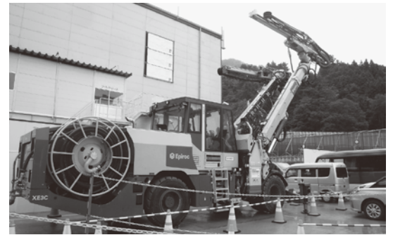
トンネル工事用の大型重機
